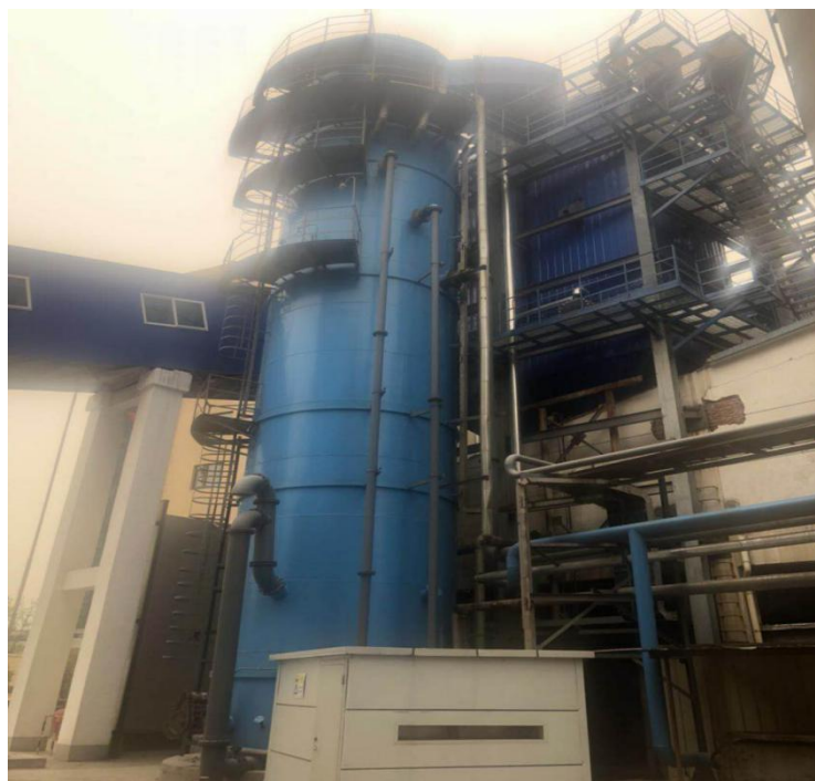
图 2-8 脱硫装置
