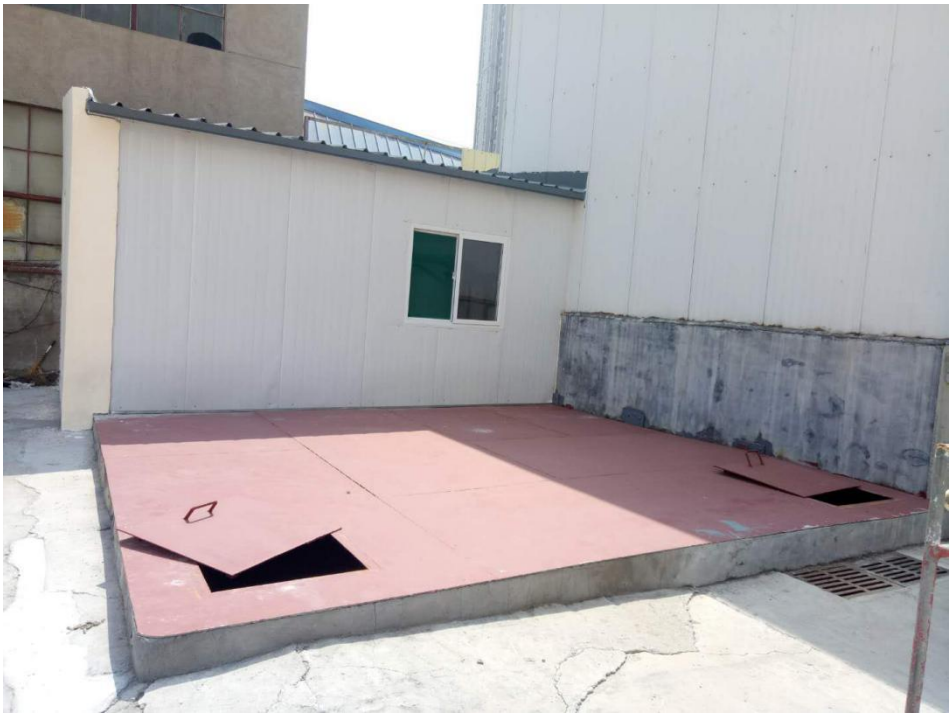
图 2-4 轻化热源厂事故应急水池
