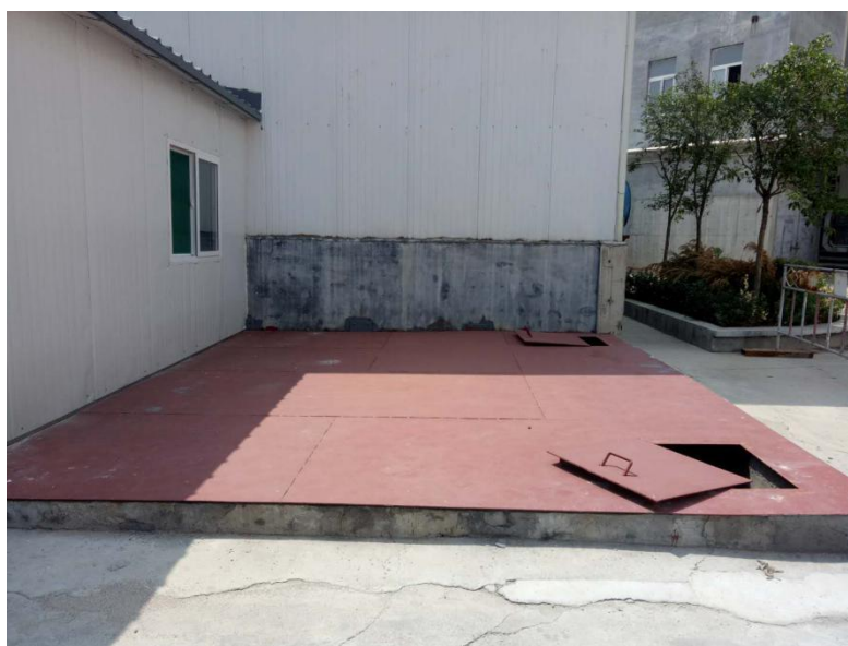
图 2-3 轻化热源厂事故应急水池
