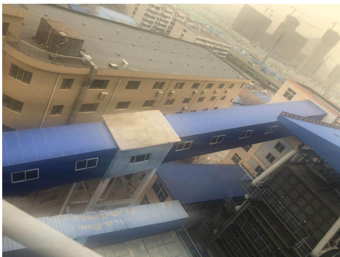
图 2-11 输煤装置
