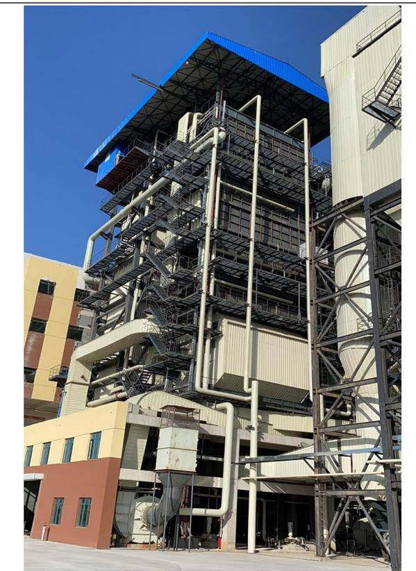
项目 6#116MW 兰炭热水锅炉
